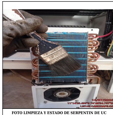
FOTO LIMPIEZA Y ESTADO DE SERPENTIN DE UC
