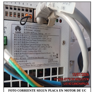
FOTO CORRIENTE SEGUN PLACA EN MOTOR DE UC
