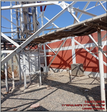
Foto Panorámica del Interior del Site
