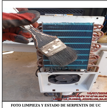
FOTO LIMPIEZA Y ESTADO DE SERPENTIN DE UC
