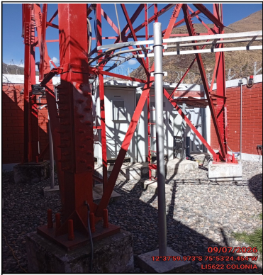
Foto Panorámica del Interior del Site
