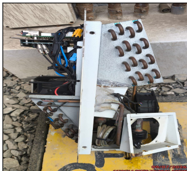
FOTO PANORAMICA DE TUBERIAS DE ALTA Y BAJA
