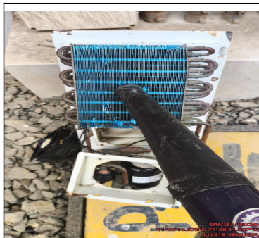
FOTO LIMPIEZA Y ESTADO DE SERPENTIN DE UC
