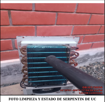
FOTO LIMPIEZA Y ESTADO DE SERPENTIN DE UC
