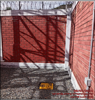
Foto Panorámica del Interior del Site
