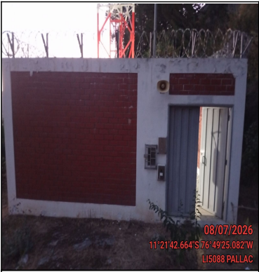
Pozo a tierra
