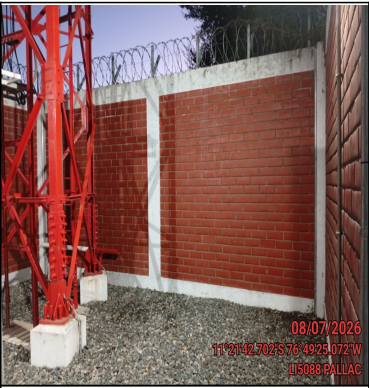
Foto Panorámica del Interior del Site
