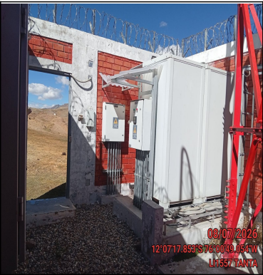
Foto Panorámica del Interior del Site
