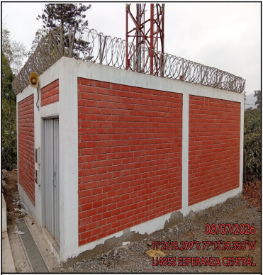
Pozo a tierra
