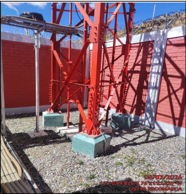
Foto Panorámica del Interior del Site
