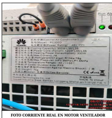
FOTO CORRIENTE REAL EN MOTOR VENTILADOR
