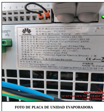
FOTO DE PLACA DE UNIDAD EVAPORADORA
