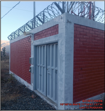
Pozo a tierra
