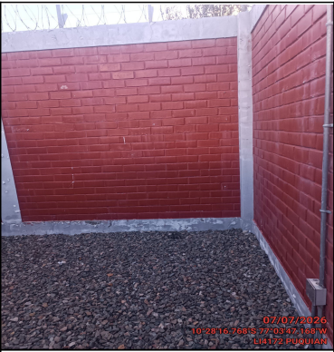
Foto Panorámica del Interior del Site
