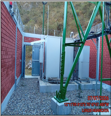
Foto Panorámica del Interior del Site
