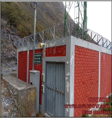
Pozo a tierra
