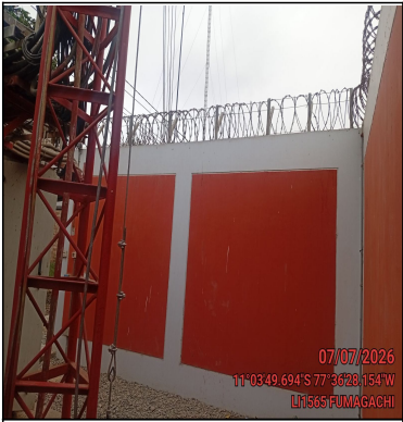
Foto Panorámica del Interior del Site
