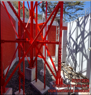
Foto Panorámica del Interior del Site
