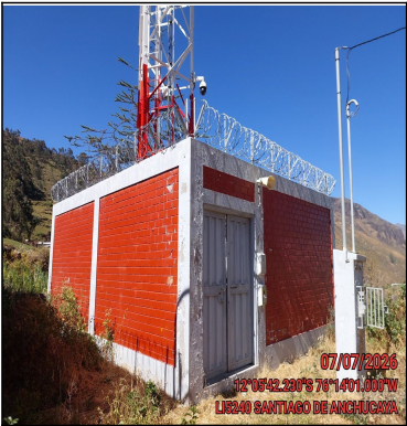
Pozo a tierra
