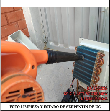
FOTO LIMPIEZA Y ESTADO DE SERPENTIN DE UC
