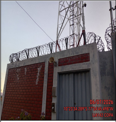
Pozo a tierra
