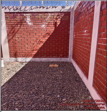
Foto Panorámica del Interior del Site
