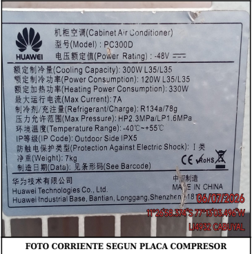
FOTO CORRIENTE SEGUN PLACA COMPRESOR
