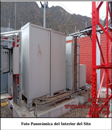
Foto Panorámica del Interior del Site
