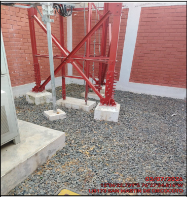
Foto Panorámica del Interior del Site
