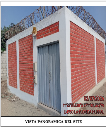
VISTA PANORAMICA DEL SITE
