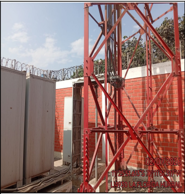
Foto Panorámica del Interior del Site
