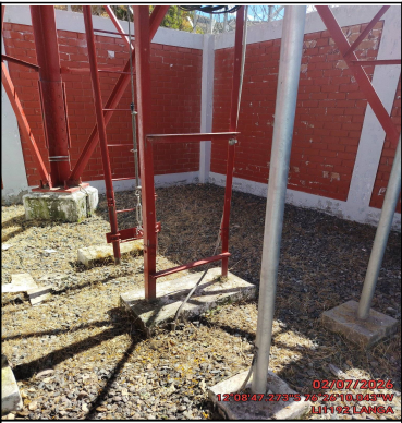
Foto Panorámica del Interior del Site
