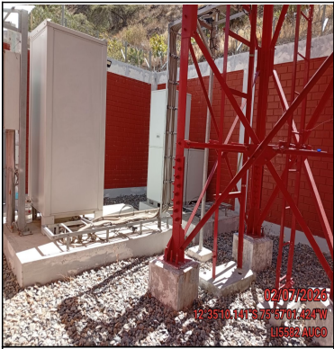
Foto Panorámica del Interior del Site
