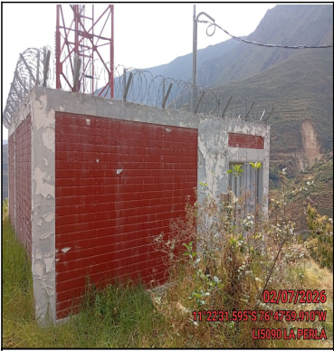
Pozo a tierra
