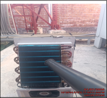
FOTO LIMPIEZA Y ESTADO DE SERPENTIN DE UC
