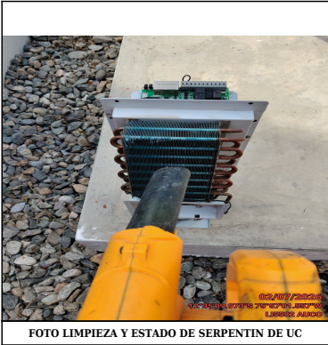
FOTO LIMPIEZA Y ESTADO DE SERPENTIN DE UC
