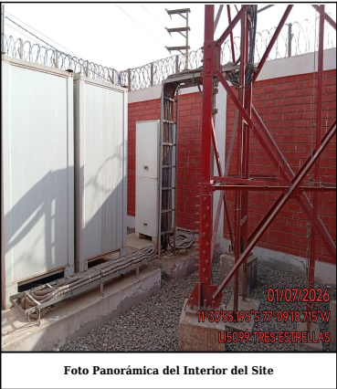
Foto Panorámica del Interior del Site
