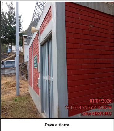
Pozo a tierra
