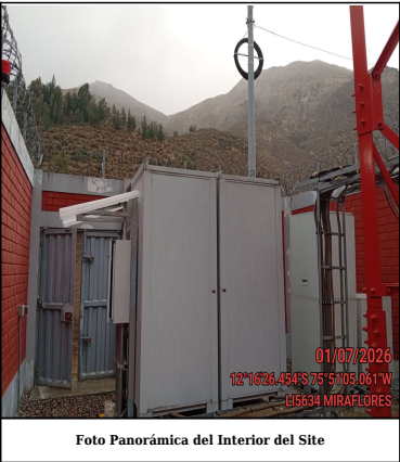
Foto Panorámica del Interior del Site
