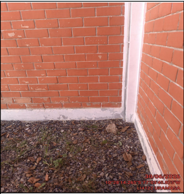
Foto Panorámica del Interior del Site
