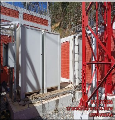
Foto Panorámica del Interior del Site
