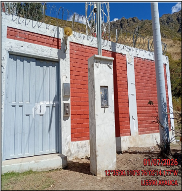
Pozo a tierra
