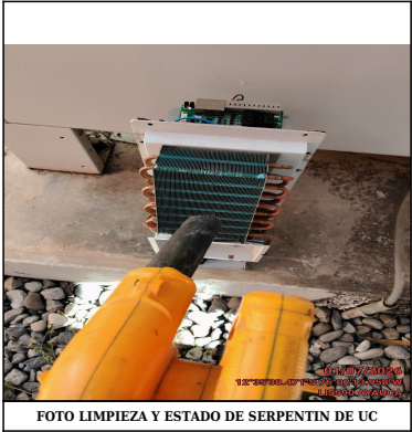
FOTO LIMPIEZA Y ESTADO DE SERPENTIN DE UC
