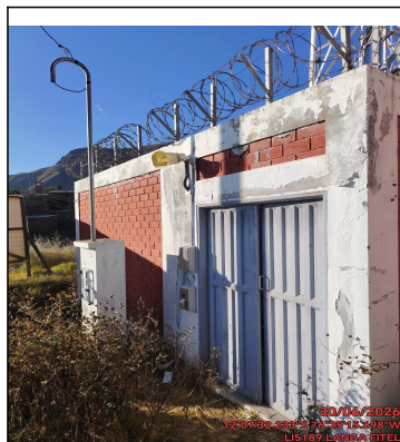
VISTA PANORAMICA DEL SITE
