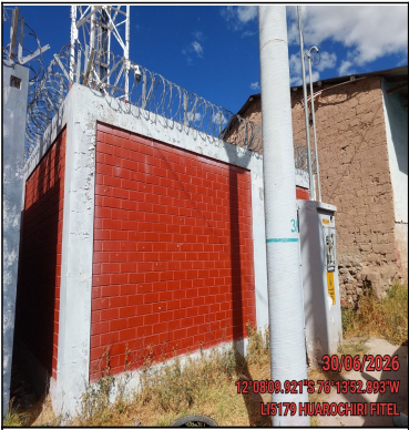
Pozo a tierra
