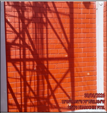
Foto Panorámica del Interior del Site
