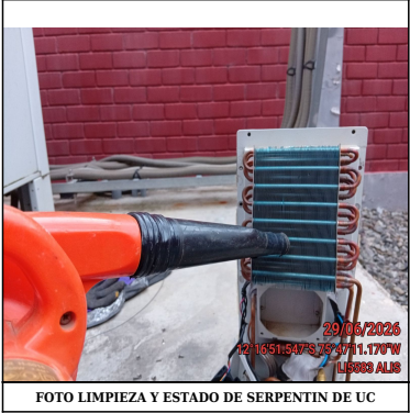
FOTO LIMPIEZA Y ESTADO DE SERPENTIN DE UC
