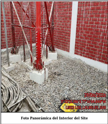
Foto Panorámica del Interior del Site
