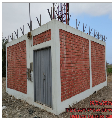
VISTA PANORAMICA DEL SITE
