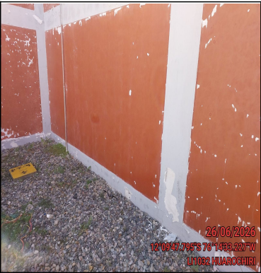
Foto Panorámica del Interior del Site
