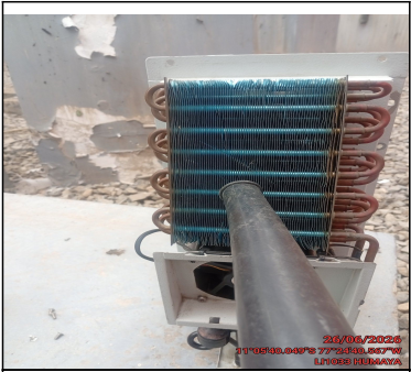
FOTO LIMPIEZA Y ESTADO DE SERPENTIN DE UC
