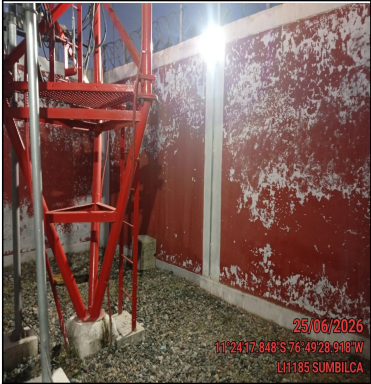
Foto Panorámica del Interior del Site
