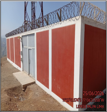
Pozo a tierra
