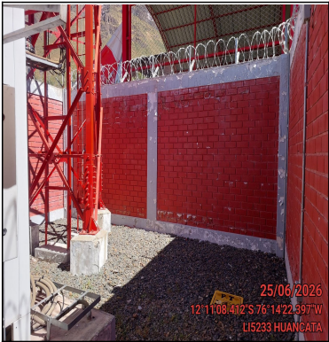
Foto Panorámica del Interior del Site
