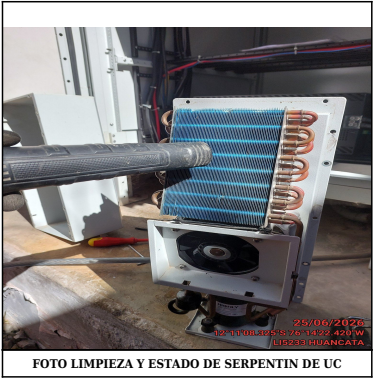
FOTO LIMPIEZA Y ESTADO DE SERPENTIN DE UC
