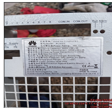
FOTO DE PLACA DE UNIDAD CONDENSADORA
