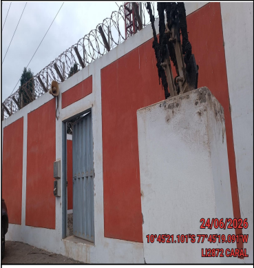
Pozo a tierra
