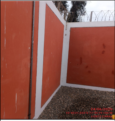
Foto Panorámica del Interior del Site
