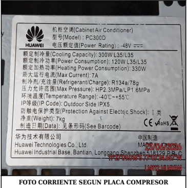
FOTO CORRIENTE SEGUN PLACA COMPRESOR
