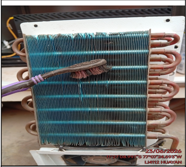
FOTO LIMPIEZA Y ESTADO DE SERPENTIN DE UC
