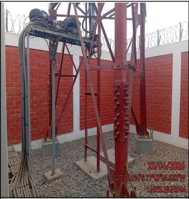
Foto Panorámica del Interior del Site
