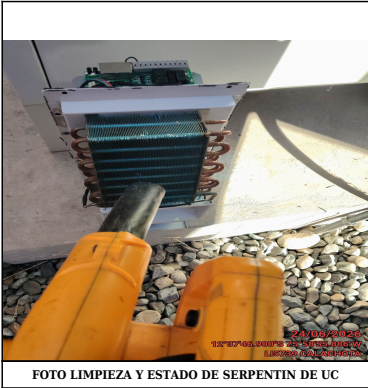
FOTO LIMPIEZA Y ESTADO DE SERPENTIN DE UC
