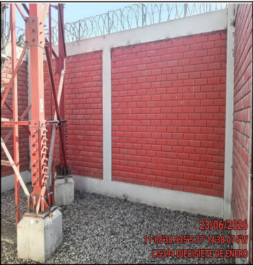
Foto Panorámica del Interior del Site
