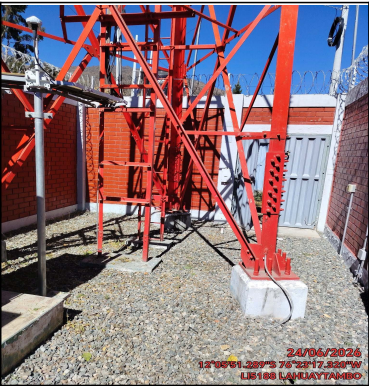
Foto Panorámica del Interior del Site
