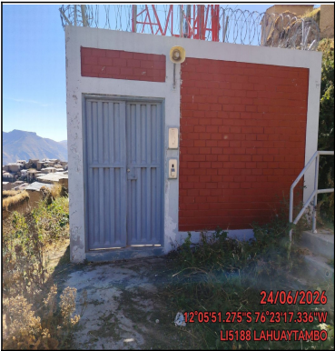
Pozo a tierra
