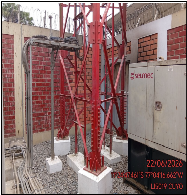
Foto Panorámica del Interior del Site
